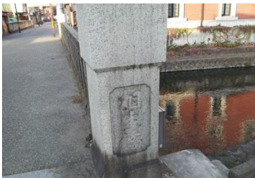
写真2 相生橋 (市内室町・境町) (平成27年11月1日撮影)
